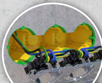
Az előhuzalozott csatlakozóaljzatok beépítése
